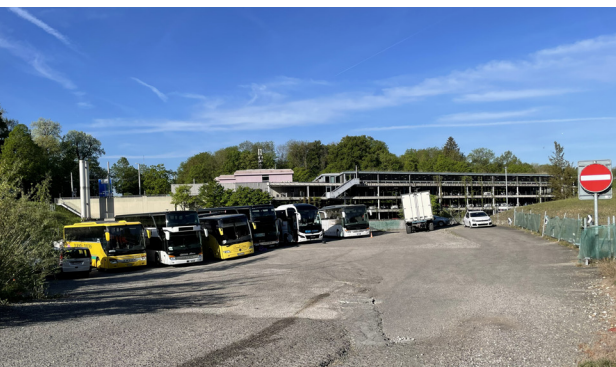
Das provisorische Carterminal Neufeld in der Nähe des Park+Ride Neufeld (im Hintergrund) ist zu klein und verfügt über kein Terminalgebäude.
