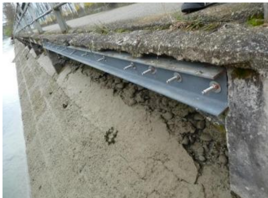
Abb. 3: Sicherung der Gehweg-Lehnenkonstruktion
