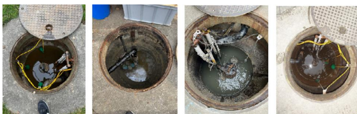
Abb. 10: diverse Hebeanlagen
