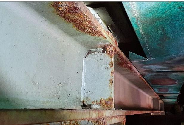
Die Kornhausbrücke wurde letztmals Ende des 20. Jahrhunderts saniert. Aktuelle Abklärungen haben ergeben, dass die Brücke in verschiedenen Bereichen Schäden aufweist. Auf dem Bild zu sehen sind Korrosionsschäden im Brückenunterbau.
