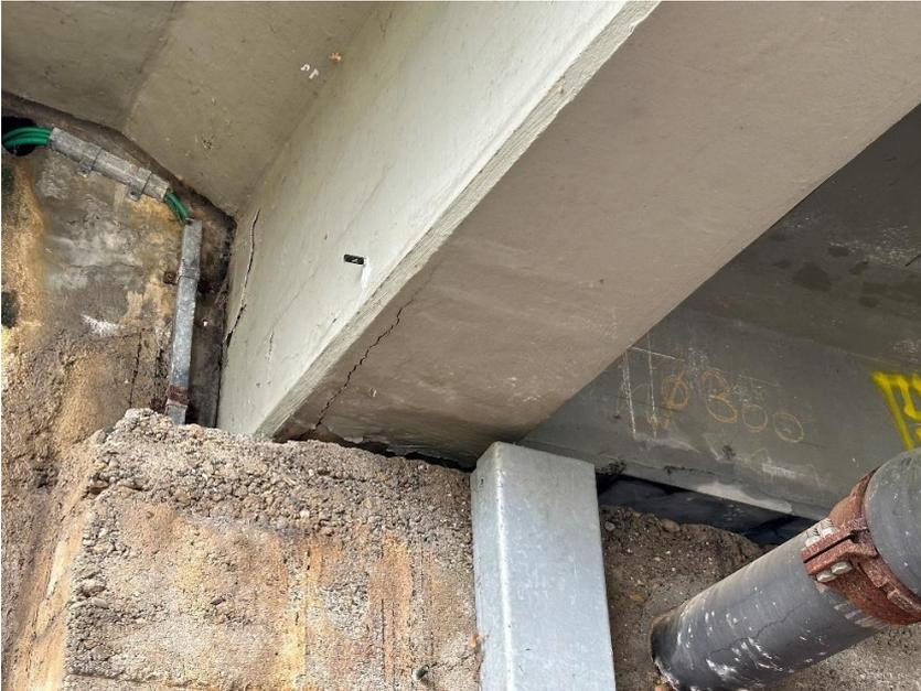
Abb. 3: Widerlager auf Seite Bremgarten: grosser Horizontalriss im Längsträger; schlechte Verdichtung und Kiesnester im Widerlager sichtbar.
