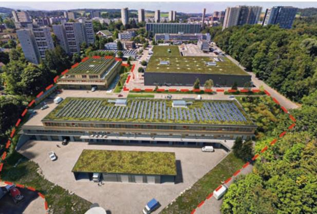
Die Visualisierung zeigt, wie sich der Gewerbebau in die bestehende Umgebung einfügt. Vorne im Bild sind der grössere Trakt sowie der Vorplatz mit Waschanlage zu sehen. Links dahinter steht der kleinere Trakt. Das Sockelgeschoss befindet sich teilweise im Untergrund. Auf den Dächern werden Photovoltaikanlagen installiert. (Visualisierung: Neuhaus AG und Design-Raum)
