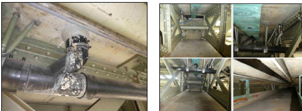
Abbildung 2: Undichte Brückenentwässerung
