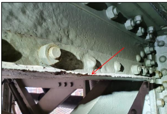
Abbildung 8+9: Korrosion an Trägern
