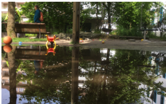
Abb. 6 und 7: Schlechte Sickerfähigkeit führt zu grossen Pfützen
