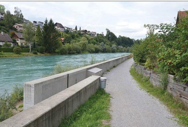
Hochwasserschutz in der Felsenau: Durch diese Mauer wird die Überschwemmungsgefahr im Uferbereich vermindert. Solche Schutzmassnahmen können zu einer Änderung der Gefährdungslage führen, was im Naturgefahrenplan berücksichtigt werden muss.
