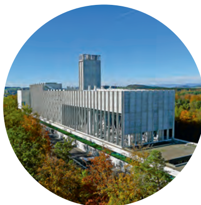
Mit der Inbetriebnahme der Fernwärmezentrale in der Energiezentrale Forsthaus wurde ein wichtiger Meilenstein erreicht.
