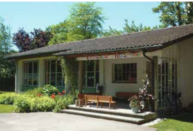
Einer der beiden Kindergartenpavillons der Volksschule Markus: Alle Gebäude der Schulanlage stammen aus den 1950er-Jahren und sind sanierungsbedürftig. Ausserdem bieten sie insbesondere für den Basisstufenunterricht zu wenig Platz.
