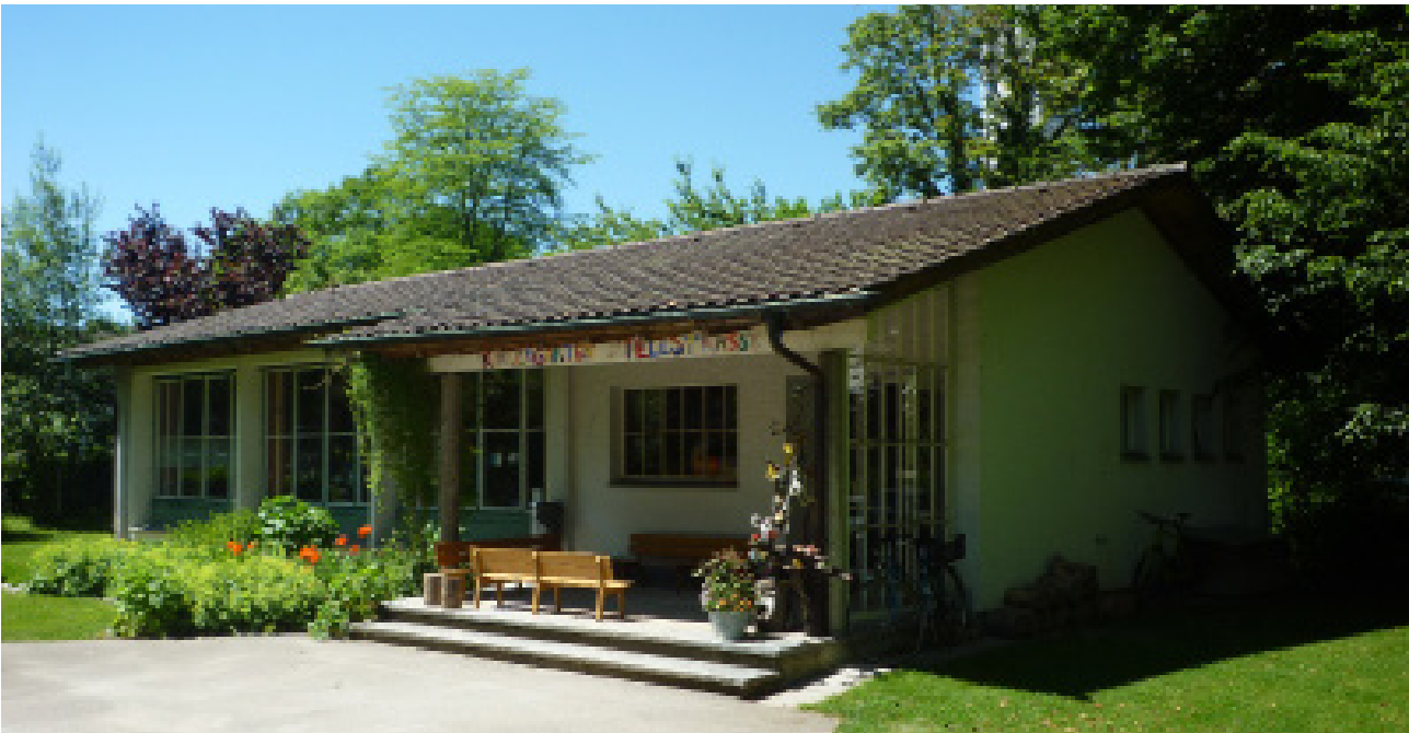
Bestand Tellstrasse Kindergarten
