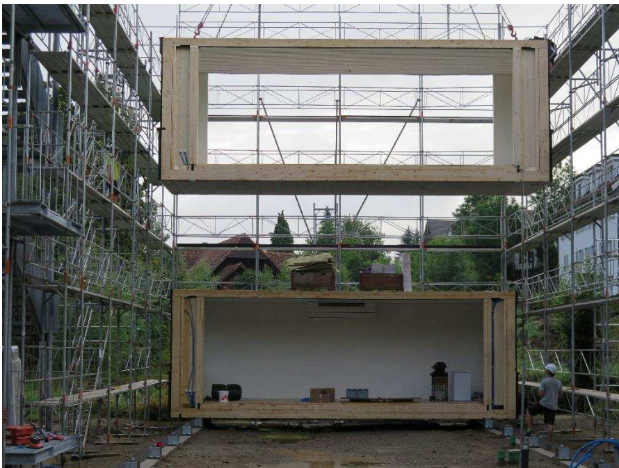
Montage Modulbauprovisorium Schulanlage Wyssloch
