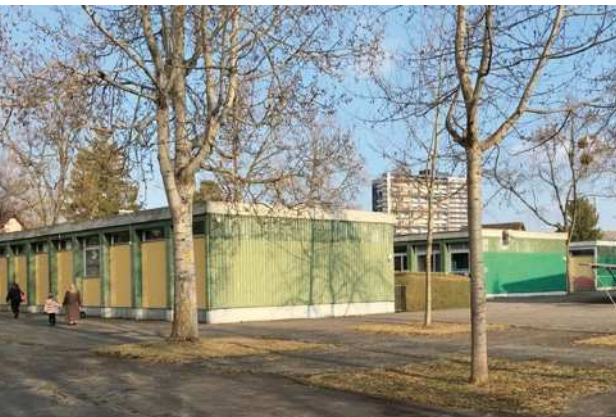
Die bestehenden Pavillons auf der Bauparzelle Brünnenstrasse 15. Sie befinden sich in einem schlechten Zustand und werden daher unabhängig vom vorliegenden Bauprojekt abgerissen.
