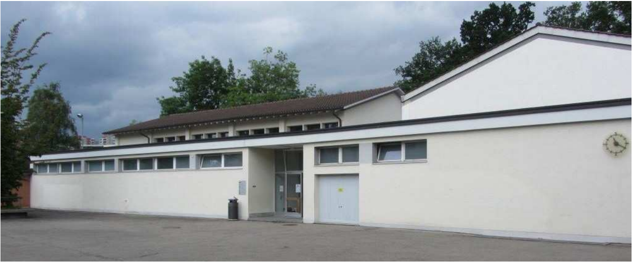
Fotografie der Eingangssituation zu den Turnhallen und Lehrschwimmbecken vor der Sanierung (Kornweg 111)
