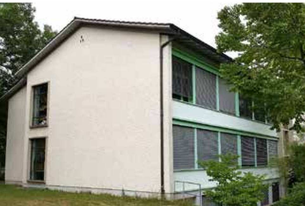
Die Schulanlage Bethlehemacker befindet sich in schlechtem baulichen Zustand. Auf dem Bild ist der sanierungsbedürftige Pavillon am Kornweg 107 zu sehen.
