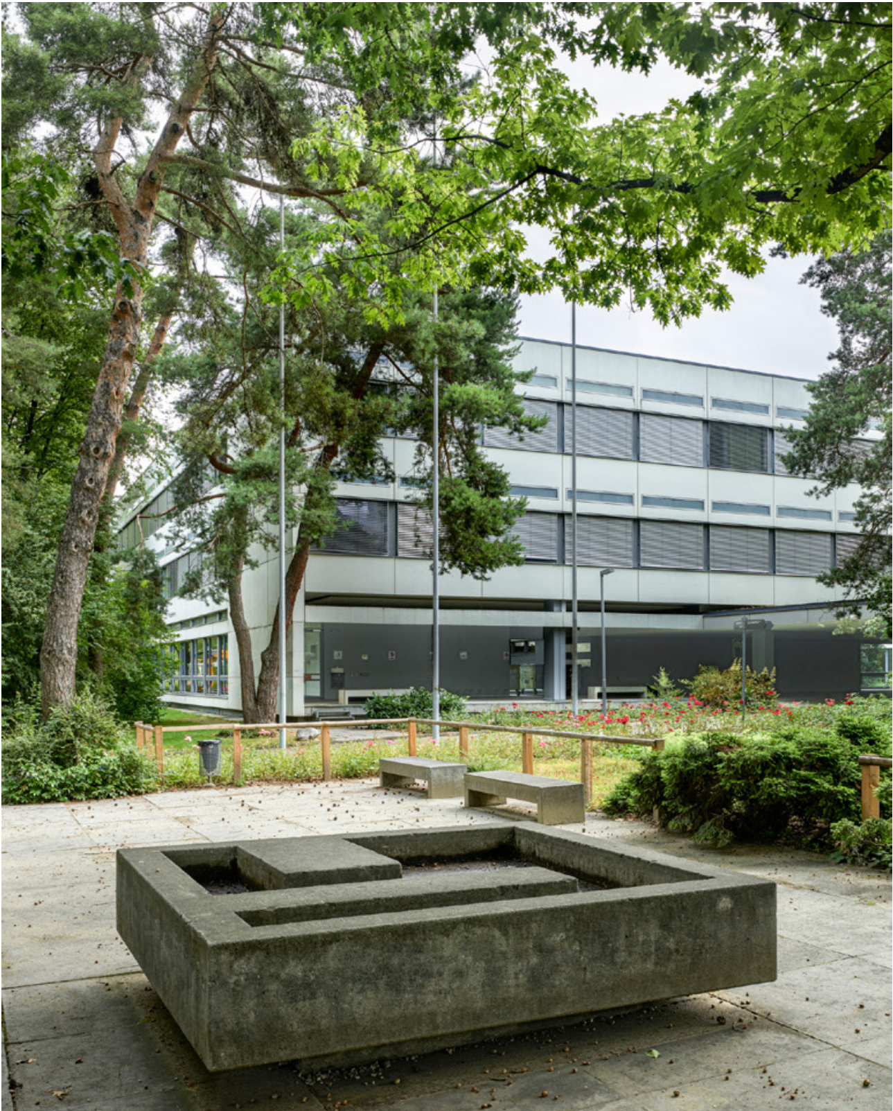
Fassade und Umgebung Schulhaus 2
