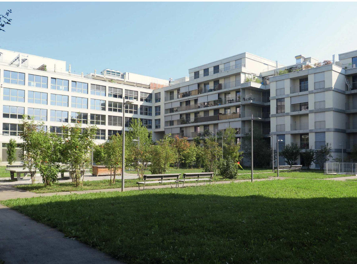
Murtenstrasse – Wohnsiedlung ARK 143
