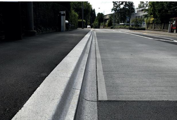
Um bei Bussen und Trams für alle Fahrgäste einen autonomen Ein- und Ausstieg zu gewährleisten, müssen die Haltekanten erhöht werden. Es werden spezielle Haltekantensteine verwendet, die das nahe Heranfahren mit Bussen ermöglichen.
