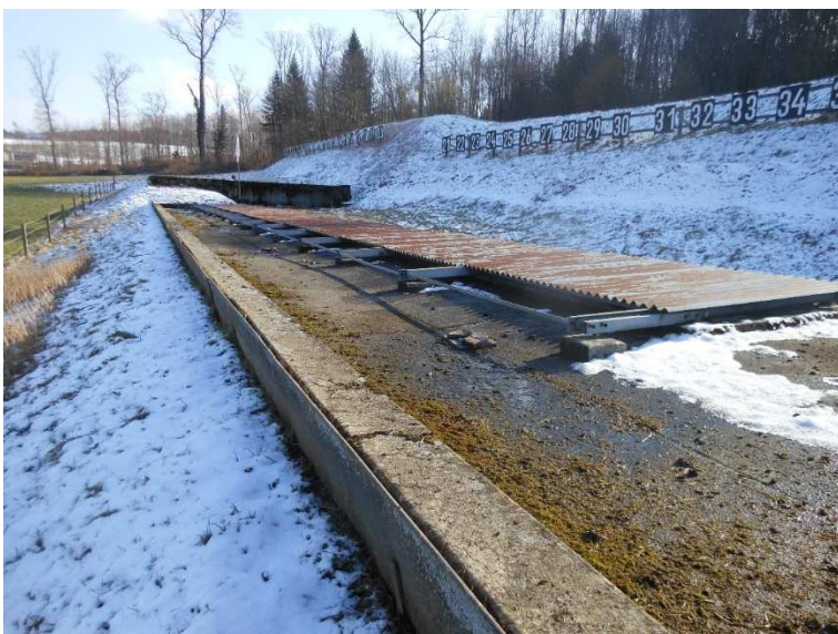
300-Meter-Stand Riedbach mit Erddamm als Kugelfang
