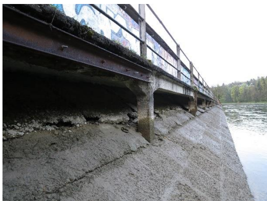
Abb. 3: Abschlussdamm und Steg auf Aareseite
