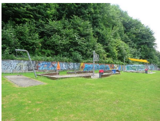
Abb. 7: Kinderspielbereich und Hangmauer
