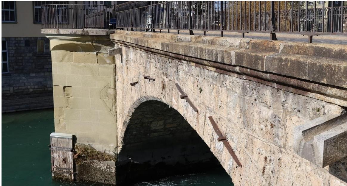
Abb. 5: Schadhafte Mauerwerk, Risse und Ausbrüche der Steine
