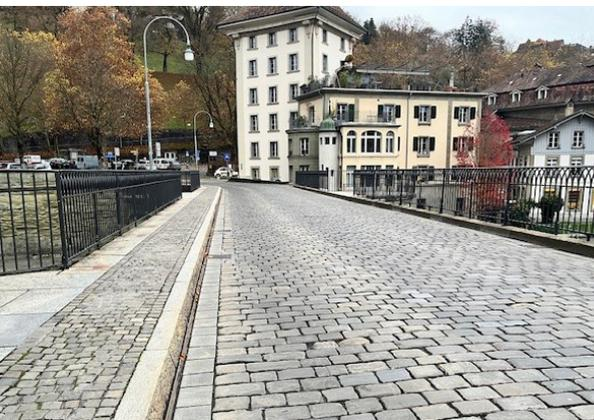
Die Pflasterung der Fahrbahn und des Trottoirs bleibt optisch unverändert, wird jedoch komplett neu verlegt. Geschliffene und geflammte Steine gewährleisten künftig die Hindernisfreiheit.
