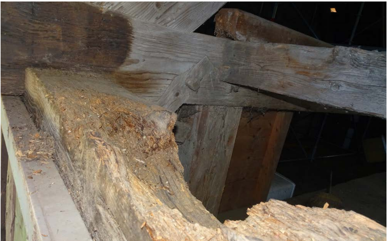
Beschädigte Dachbalken
