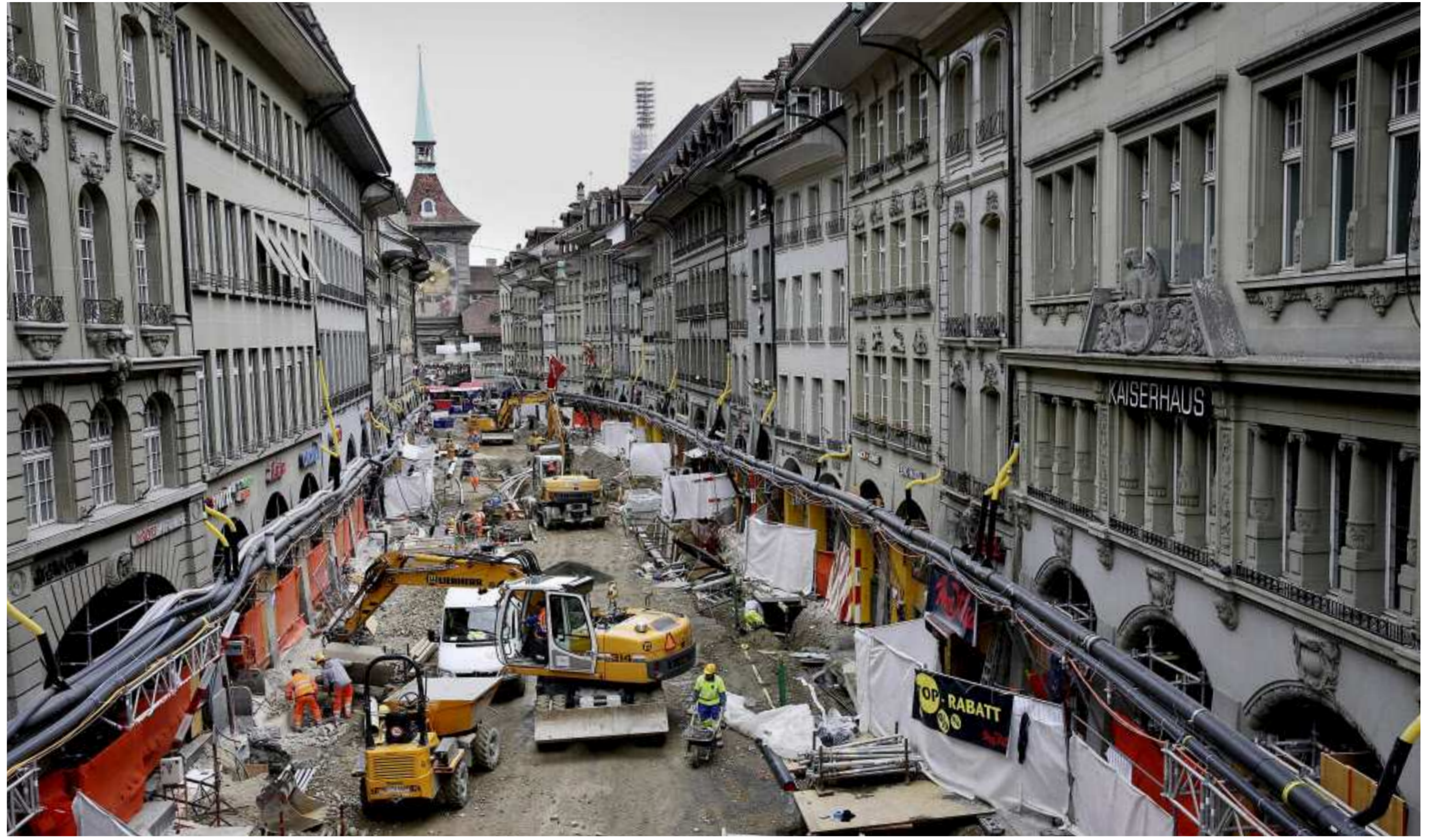
Mega-Baustelle in der Berner Marktgasse: Geschäfte leiden wegen fehlender Kundschaft.
