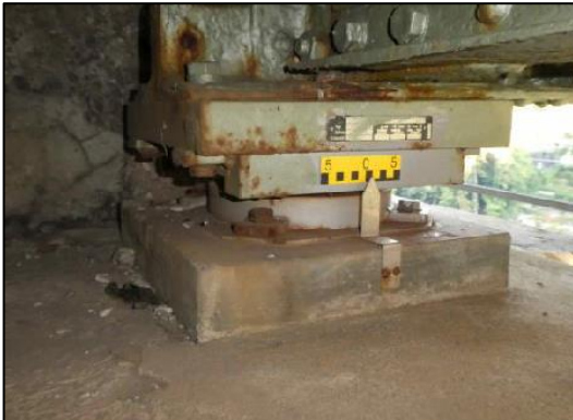
Abbildungen 5+6: Defekte und ungenügende Widerlager
