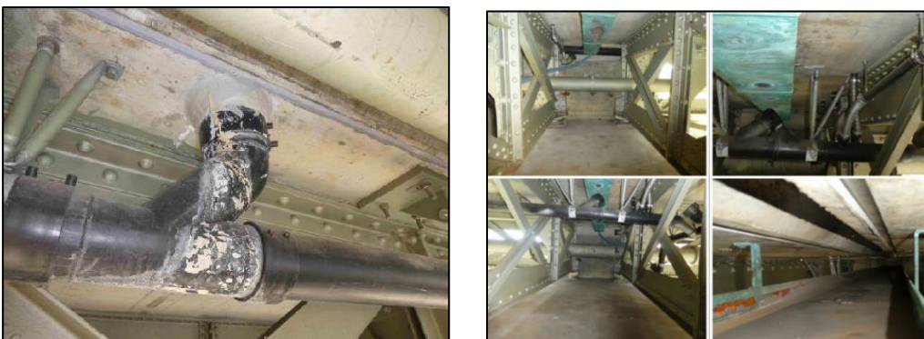
Abbildung 2: Undichte Brückenentwässerung
