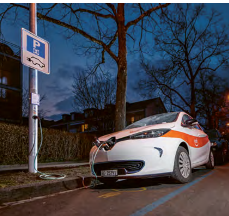
Laden eines E-Fahrzeugs an einer Strassenlaterne
