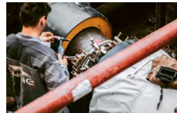
Fernwärme-Rohre werden zusammenschweisst.
