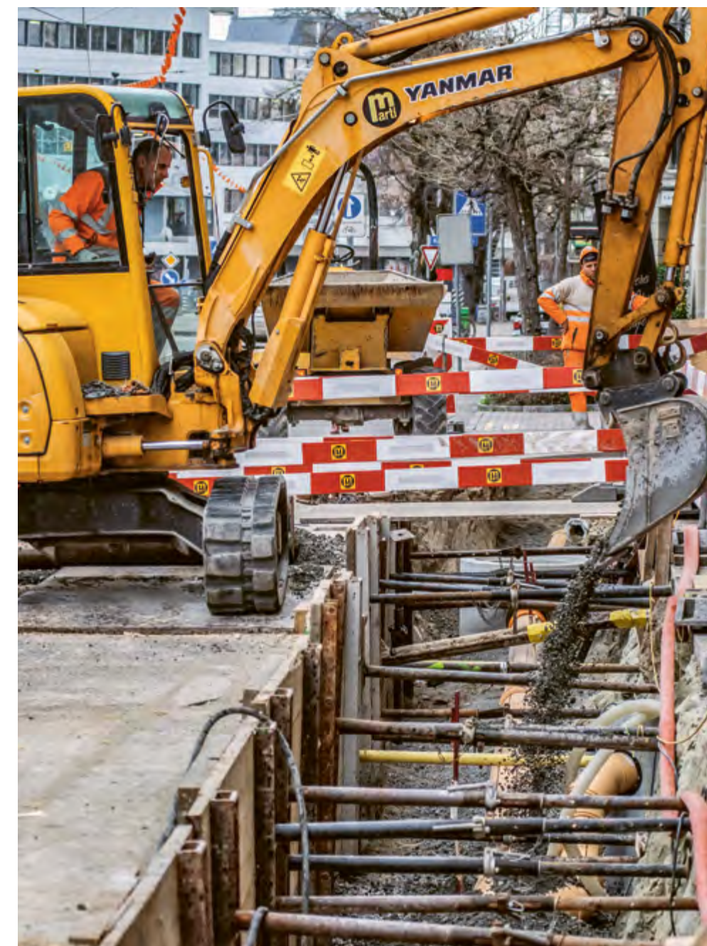
Bild 2 und 3: Werkleitungssanierungen im «nöien Breitsch».
