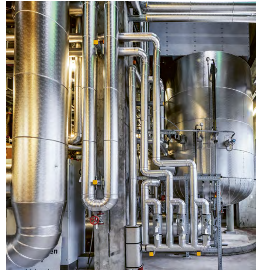
Bild 1: Der Elektrodendampfkessel trägt zur Netzstabilität bei.
