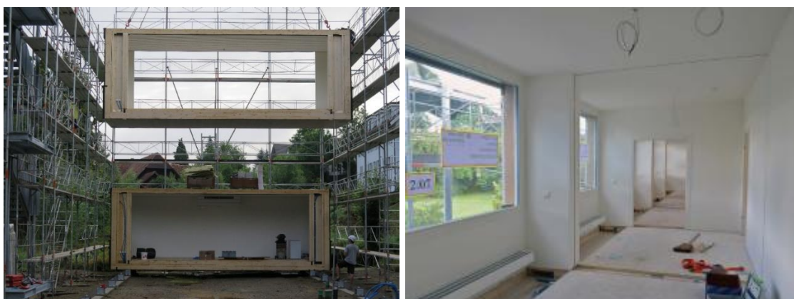
Montage der Holzmodule für das Provisorium im Wyssloch
