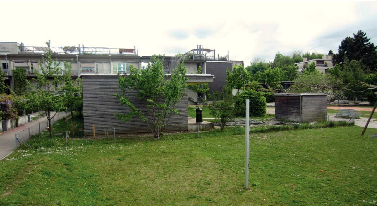
Baufeld für den Erweiterungsbau nordwestseitig des bestehenden Kindergartens
