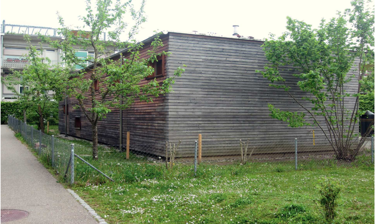
Fassade des bestehenden Kindergartens
