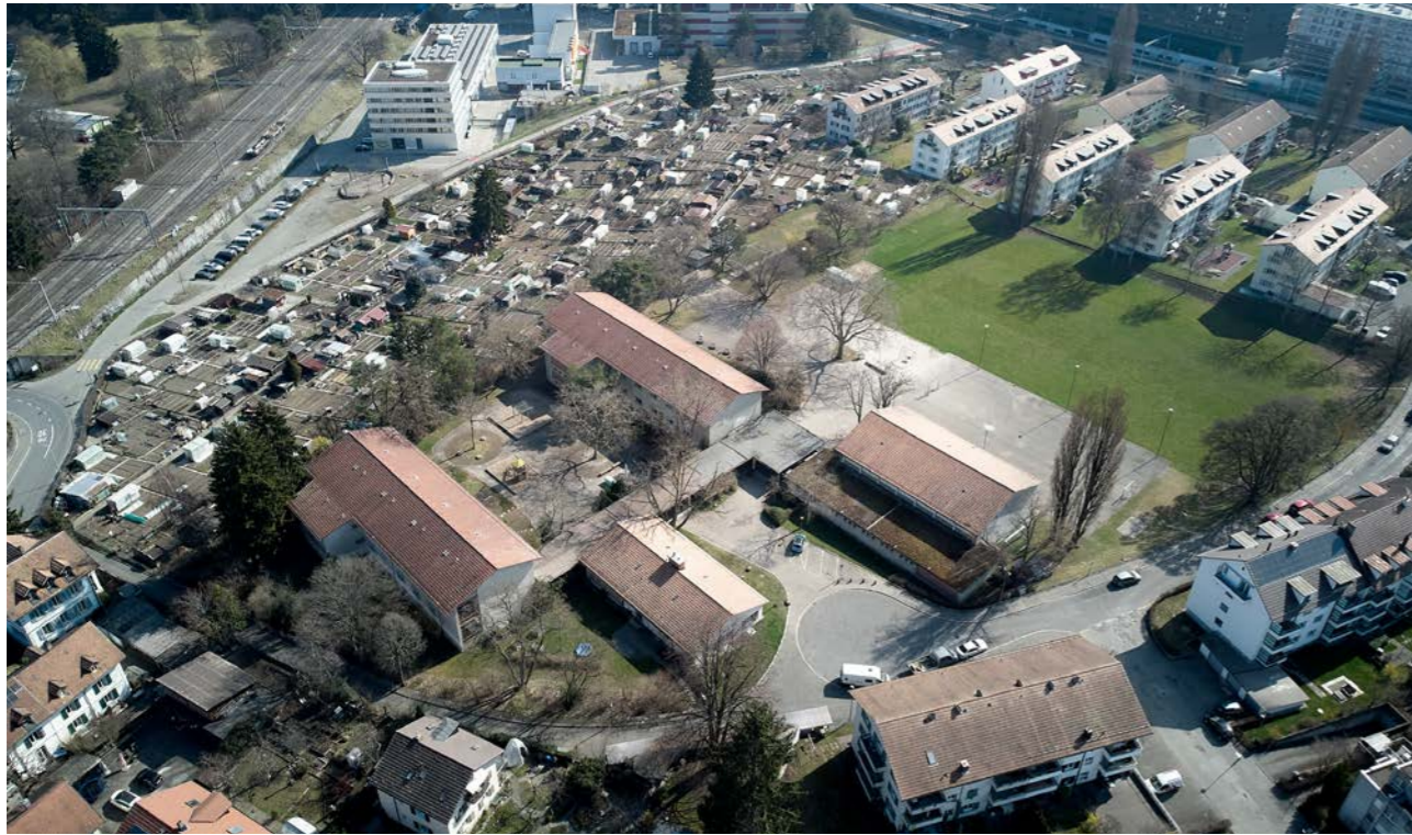
Schulanlage von Oben
