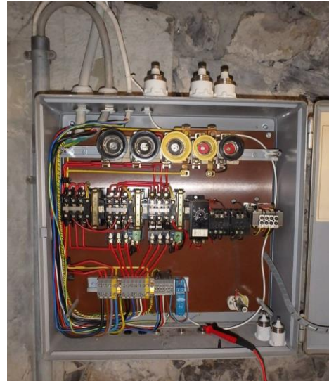
Abbildung 4: Steuerung veraltet/ausgefallen
