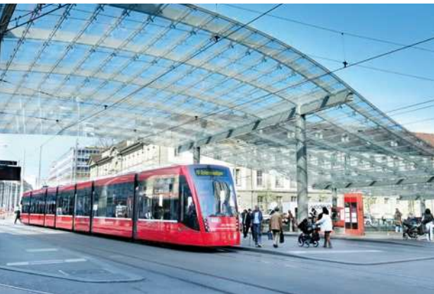
Tram statt Bus: Das Projekt Tram Bern Ostermundigen sieht vor, den östlichen Ast der Linie 10 auf Trambetrieb umzustellen, um über genügend Transportkapazität auf dieser stark frequentierten Linie zu verfügen.
