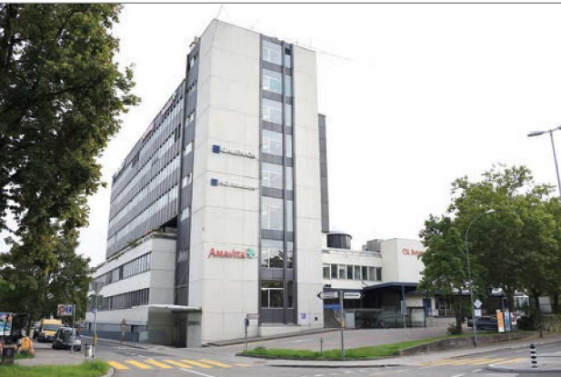
Der heutige Hauptsitz der Galenica Gruppe am Untermattweg 8: Blick von der Murtenstrasse auf den Haupteingang im Norden.
