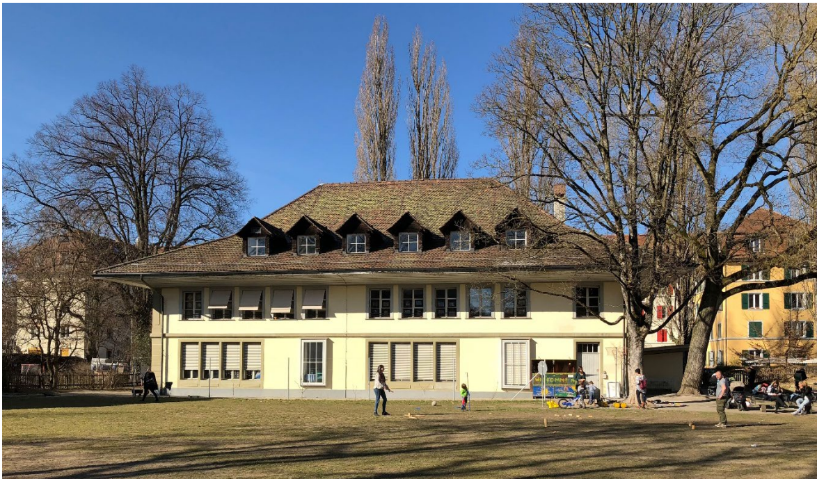
Südfassade Volksschule Steckgut
