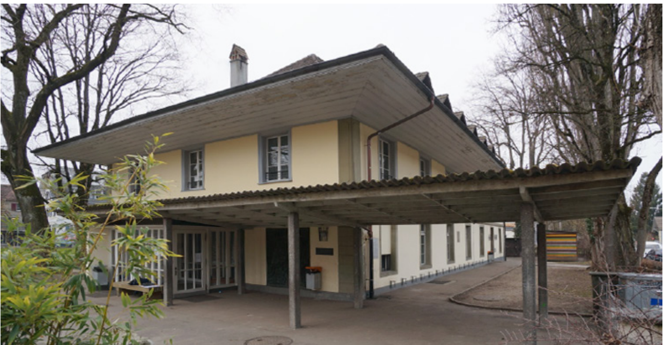
Bestand: Haupteingang mit Vordach
