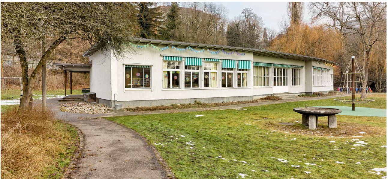
Kindergarten und Unterstufe Pavillon Brückenstrasse 70
