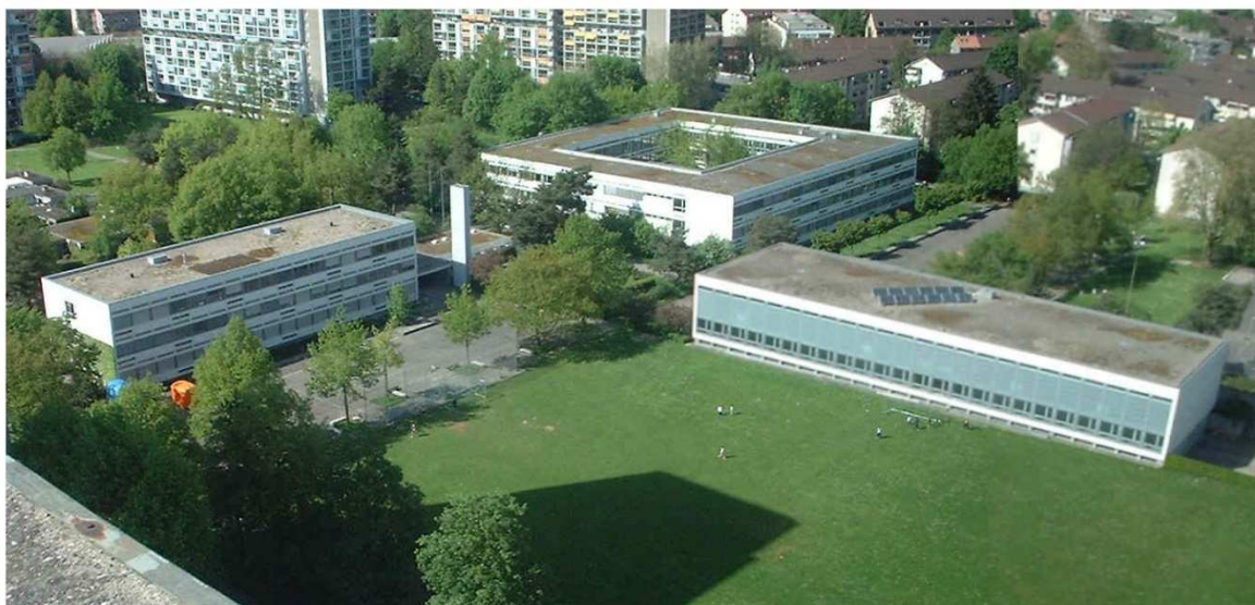
Schulanlage Schwabgut mit Primarschulhaus (Schwabgut 1), Sekundarschulhaus mit Aula (Schwabgut 2) und Turnhalle
