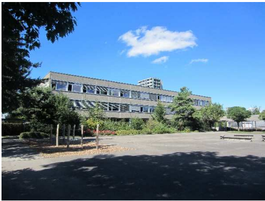
Mittelstufentrakt (ursprünglich Oberstufentrakt)
