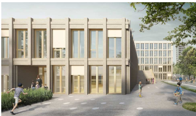
Gebäude Basisstufe – Ansicht von der Rehlagstrasse, im Hintergrund das Primarstufengebäude
