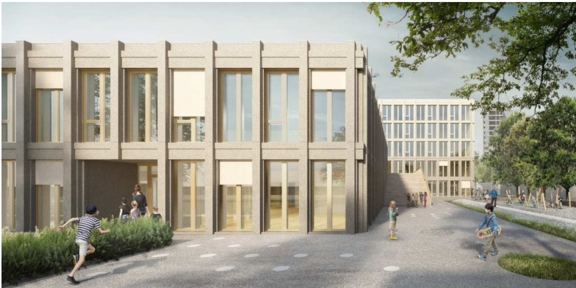
Gebäude Basisstufe – Ansicht von der Rehhagstrasse, im Hintergrund das Gebäude Primarstufe
