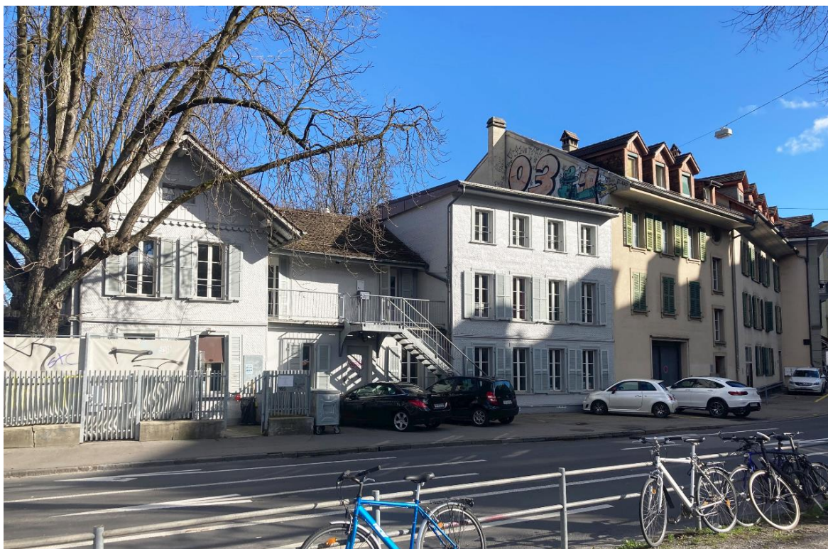
Abbildung 1: Gebäudezeile Hodlerstrasse 18-22 (v.r.n.l.)
