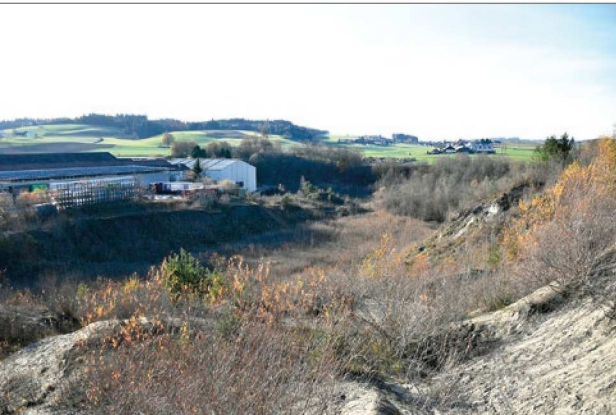
Blick von Nordosten über das Areal Rehhag nach Westen: In der alten Tongrube werden seit rund 16 Jahren keine Rohstoffe für die Ziegelproduktion mehr abgebaut. Am oberen Bildrand liegt links das Betriebsareal und rechts Oberbottigen.
