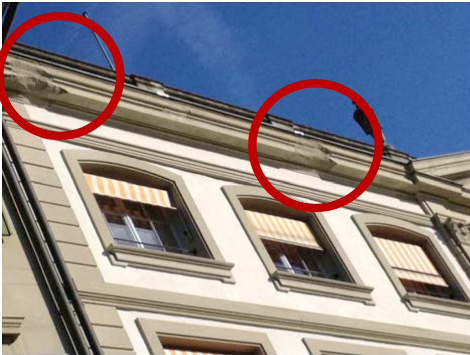
Südfassade mit abgebrochenem Dachgesims (rot)
