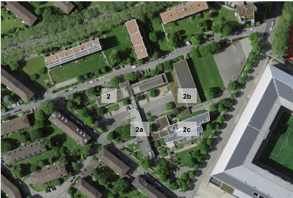
Situation: Morgartenstrasse 2 (Volksschule), 2a (AfU, Ganztagesbasisstufe, Schulleitungsbüros), 2b (Turnhalle) und 2c (Sprachheilschule)
